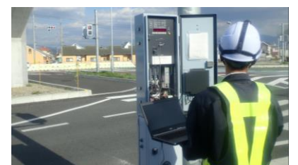
【信号サイクルの調整作業】
